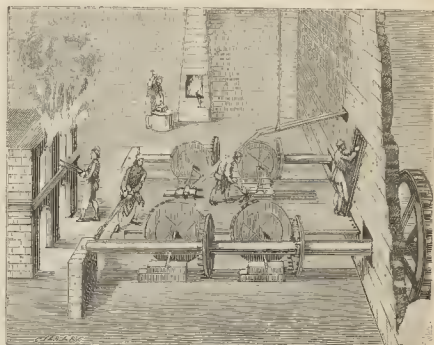
Fig. 3. Instalación antigua de fundición
